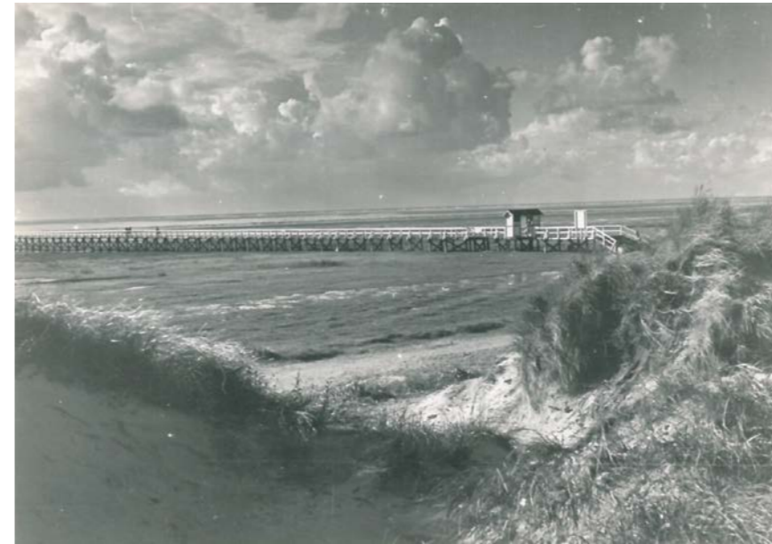
Seebrücke 1926 ↑ die „Giftbude“ → (Bilder: Ortschronik AG)
